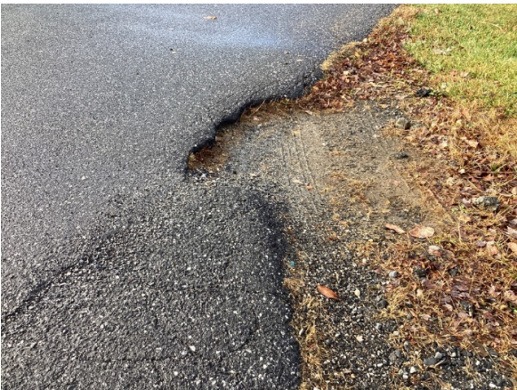
2004 edge deterioration
