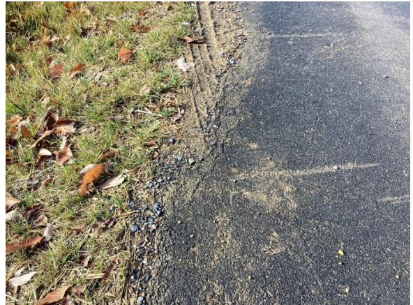
2004 edge deterioration
